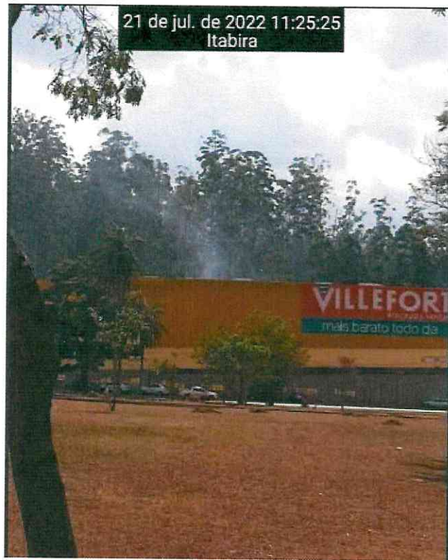
Figura 2.2 – Foco de incêndio atrás do Ville Forte
